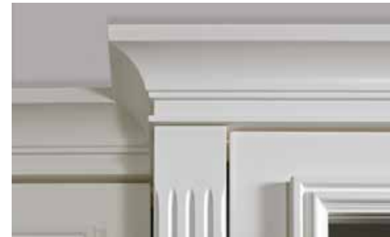
Kannelierter Pilaster und Kranz Fluted pilaster and cornice
