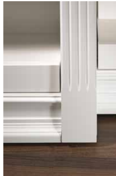
Sockellösung und kannelierte Pilaster Plinth solution and fluted pilaster strips
